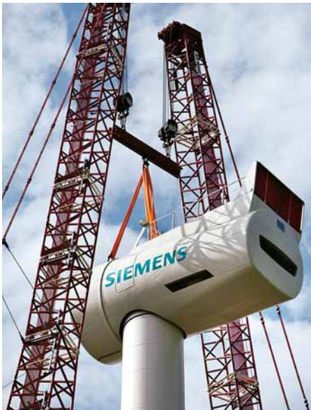
Großes Leichtgewicht: Siemens entwickelte die getriebelose 6-MW-Turbine speziell für die rauen Bedingungen auf See (links der Aufbau für den Testbetrieb).
