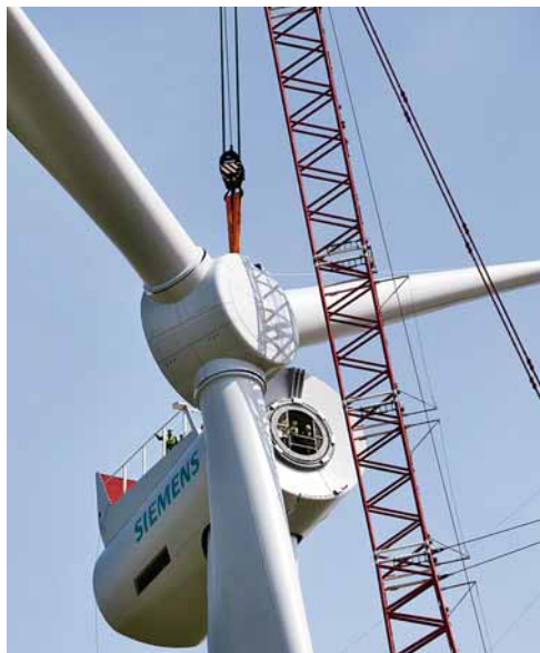
Großes Leichtgewicht: Siemens entwickelte die getriebelose 6-MW-Turbine speziell für die rauen Bedingungen auf See (links der Aufbau für den Testbetrieb).
