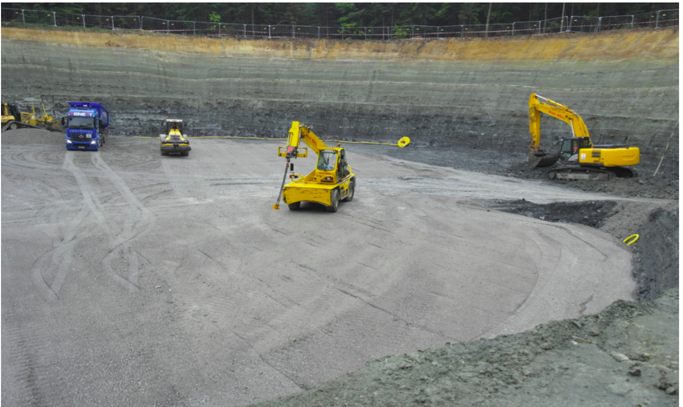
Die etwa 10 Meter tiefe Baugrube lässt die Baustellenfahrzeuge aussehen wie Spielzeugbagger.
