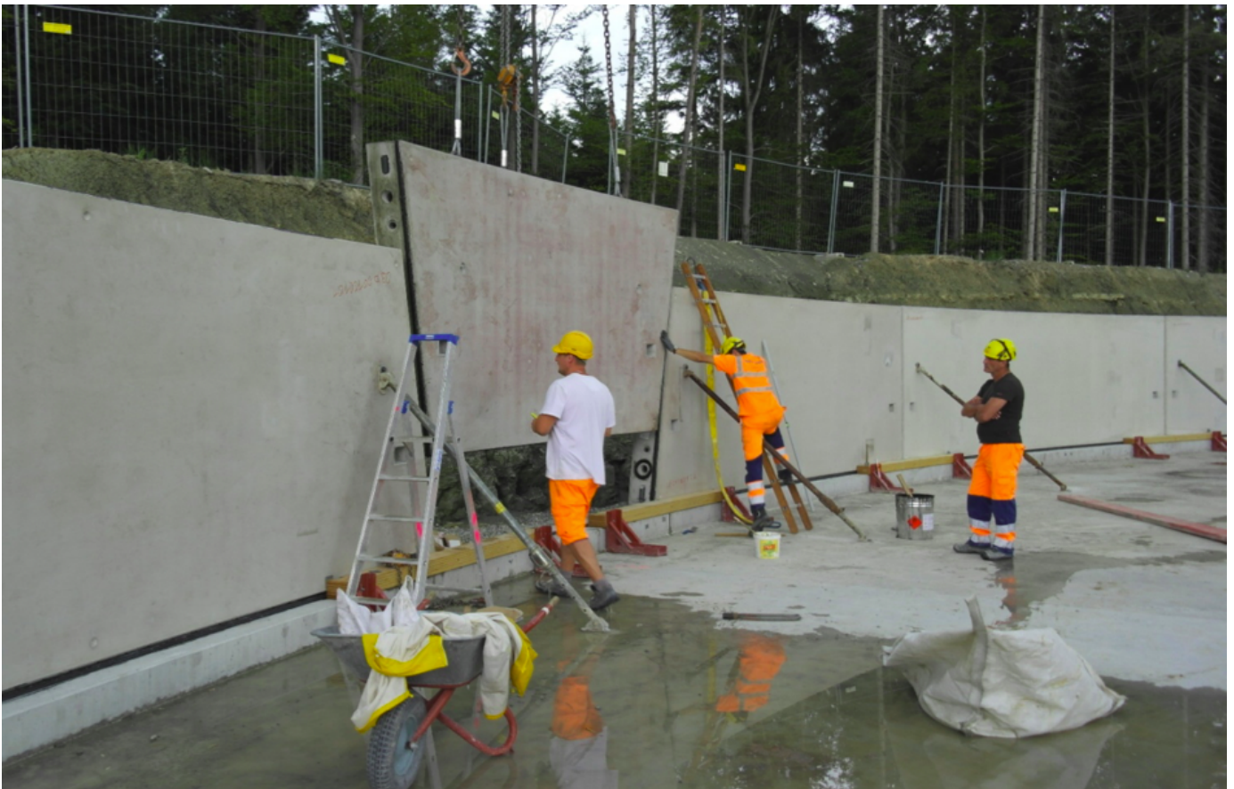
Mit dem letzten Tübbing schließen die Monteure den ersten Ring des Passivbeckens.
