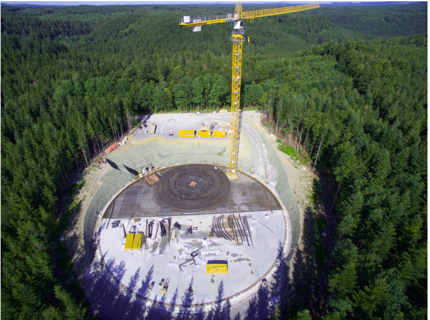
Blick auf die Baustelle der WEA 5 am 30. Juli 2016.
