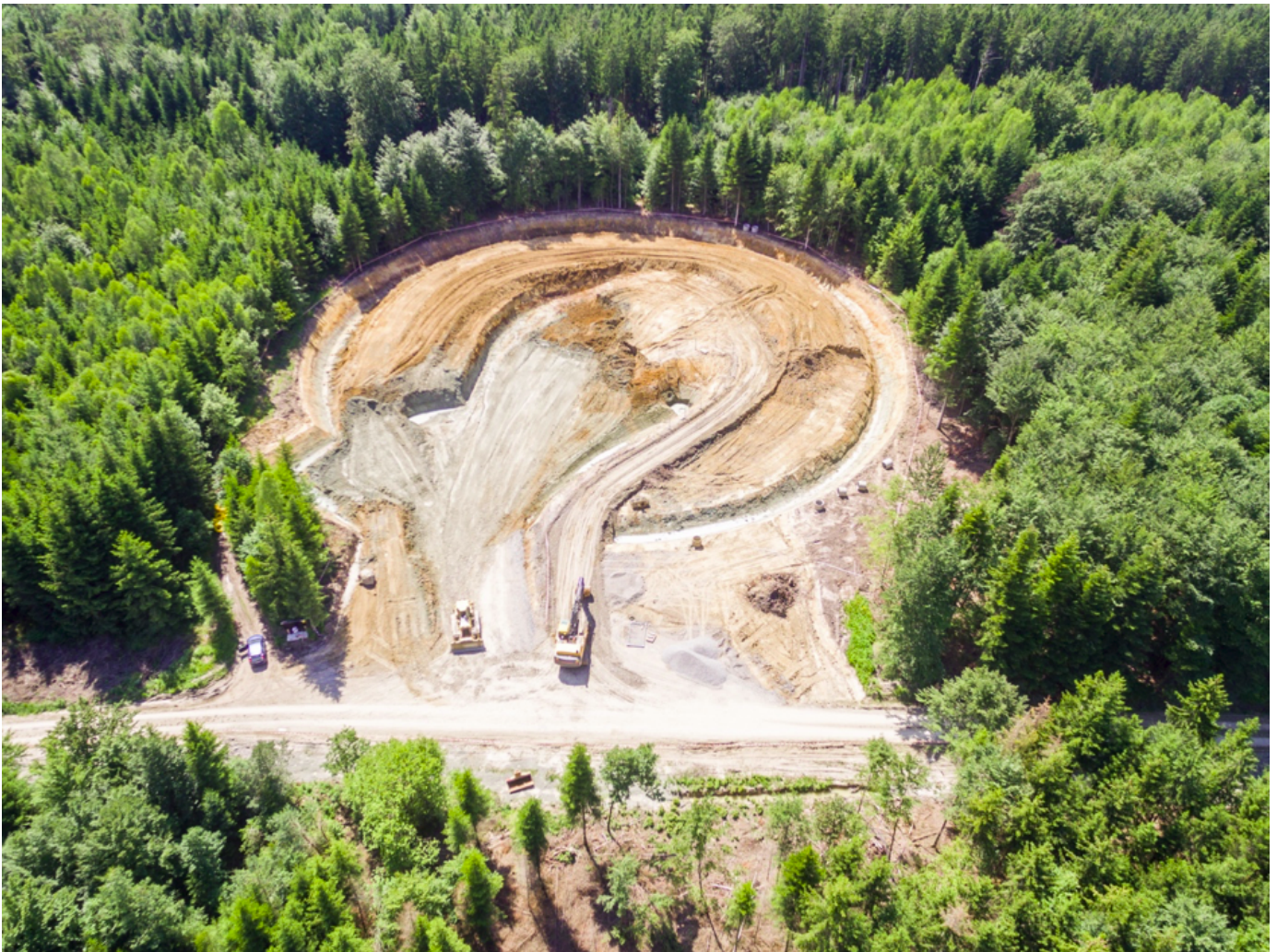
Arbeiten auf der Baustelle bei bestem Wetter.
