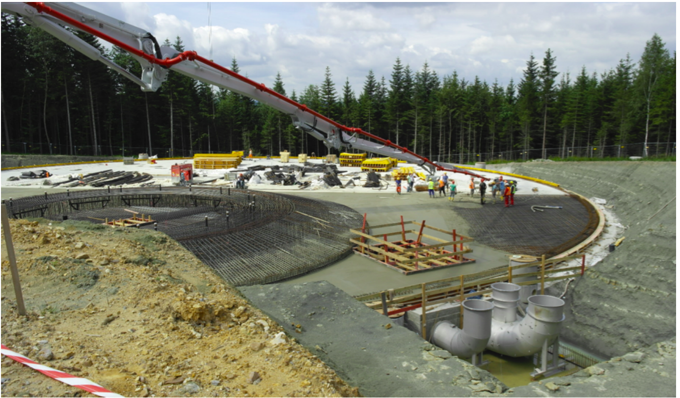
Betonarbeiten an der WEA 5.
