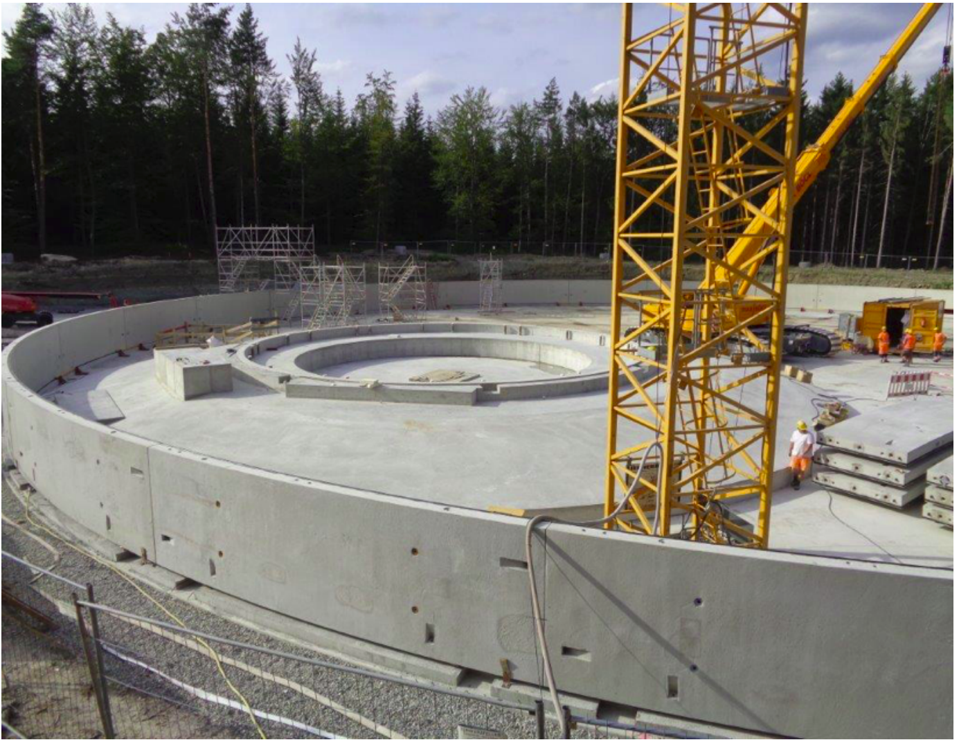
Ein paar Tage später: die Baustelle der WEA 3 hat sich deutlich verändert.
