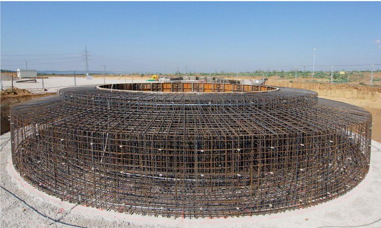
Fundamentarmierung für Windindustrieanlage Enercon E82 in Ingersheim
