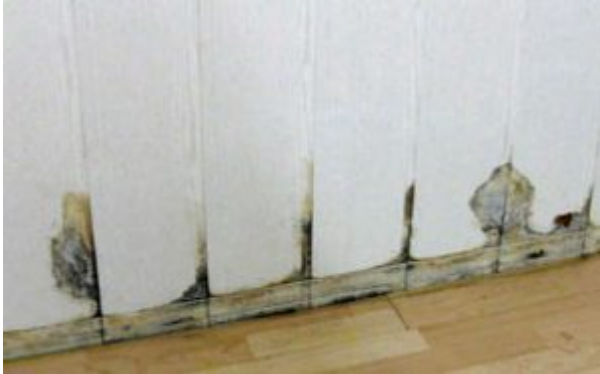
Massiver Schimmelbefall im feuchten Bereich einer Wandverkleidung.
