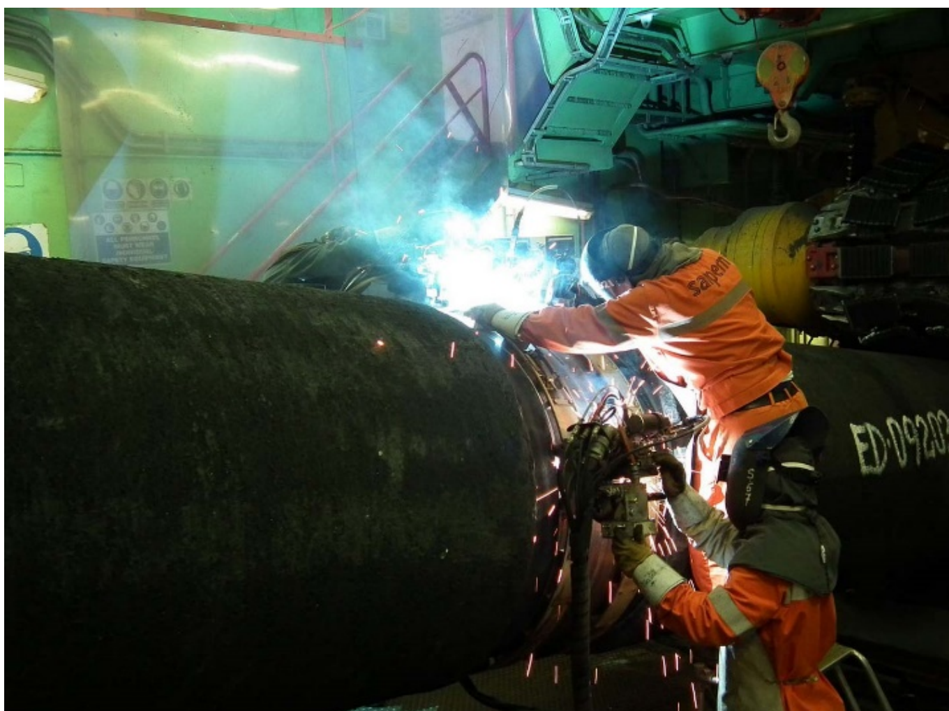
Schweißarbeiten an der Pipeline Nord Stream I (Bild: Bair175 , Creative Commons Attribution-Share Alike 3.0 Unported )
