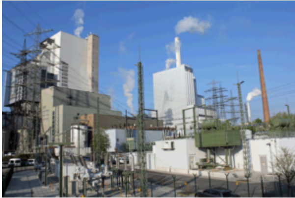
Großkraftwerk Mannheim mit neuer KWK Anlage
