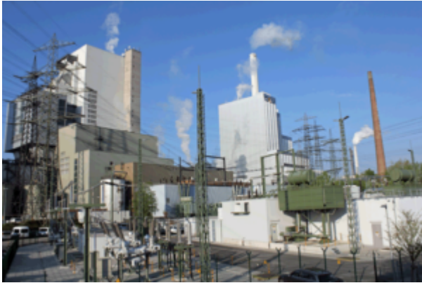
Großkraftwerk Mannheim mit neuer KWK Anlage
